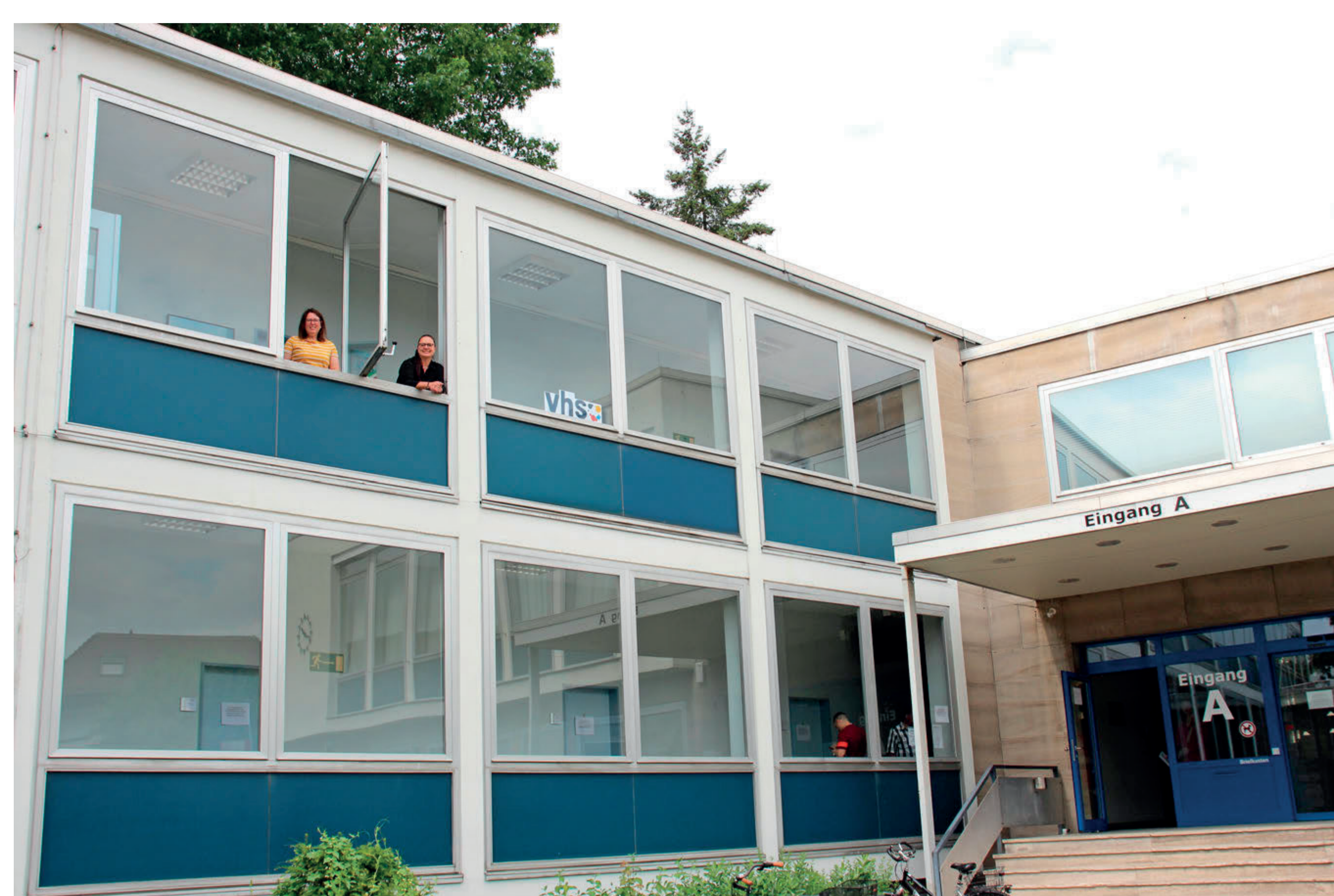
Rathaus Obertshausen, vhs Büro, 1. OG
